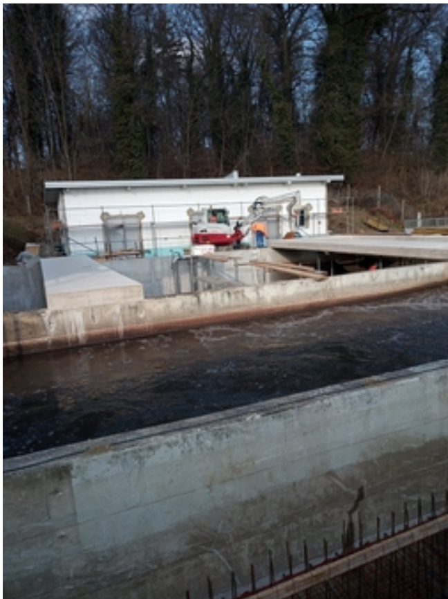
Slika3: Po opaženju so delavci že vlili betonsko ploščo nad bazen
