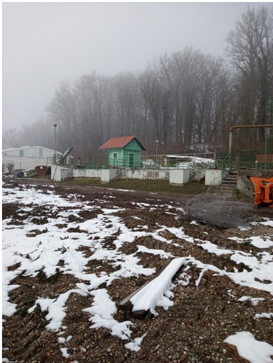
Slika1: Delovišče ob začetku rekonstrukcije in nadgradnje čistilne naprave
