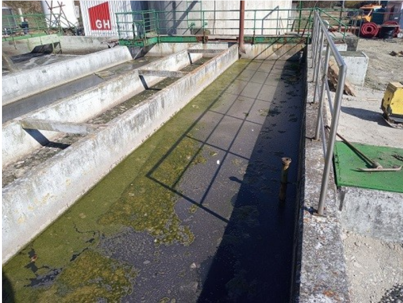
Slika 2: Obstoječi bazen čistilne naprave
